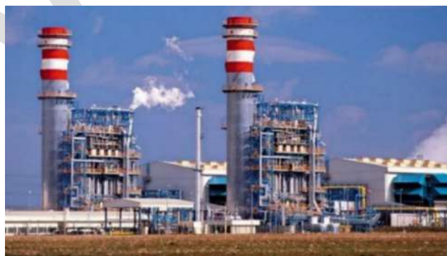
Figura 5 - Central Termoelétrica de Ciclo Combinando, no Soyo
