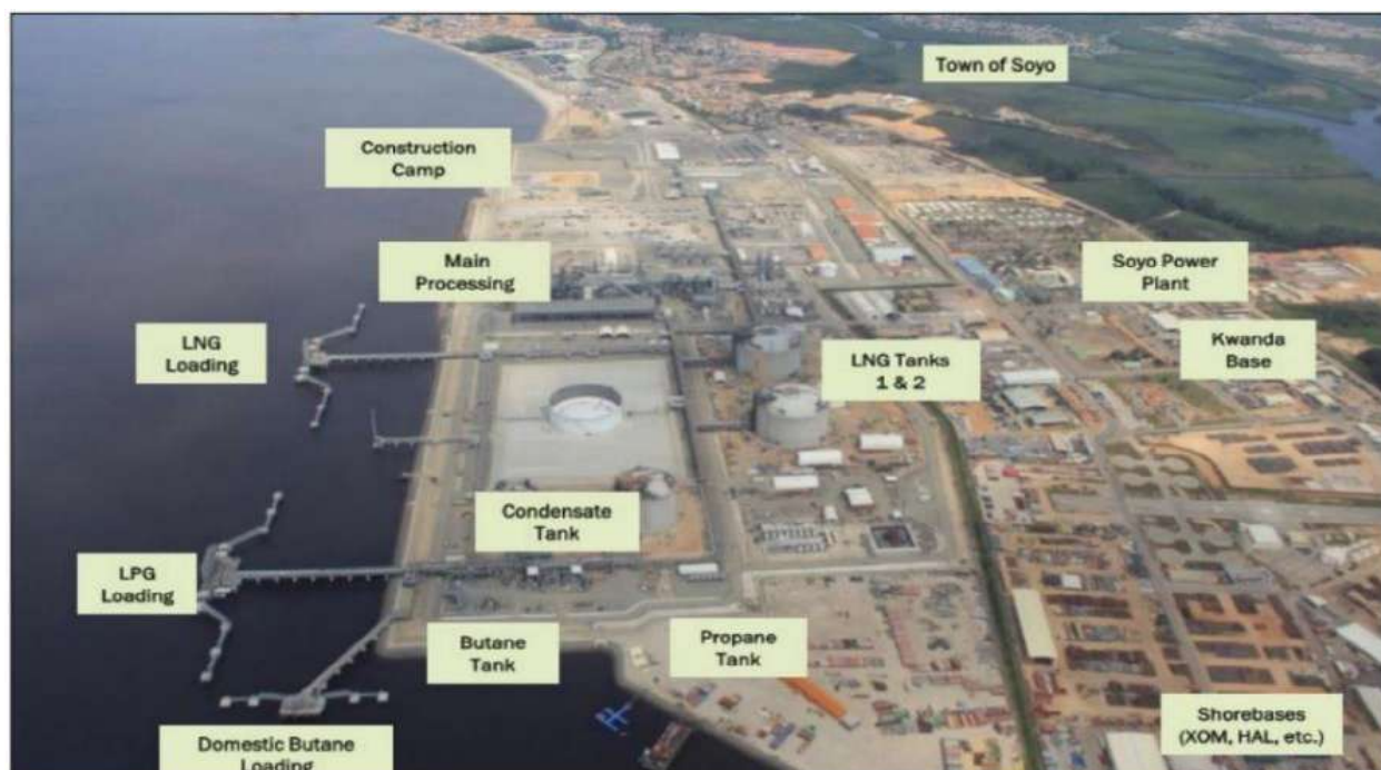
Figura 4 - Fábrica Angola LNG. Fonte: ALNG
